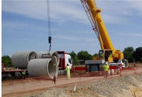
A través de **pinza para tubos** (en este caso, el útil siempre se colocará en el extremo hembra).
