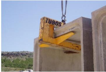
A través de **pinza para marcos** (en este caso, el útil siempre se colocará en el extremo hembra)
