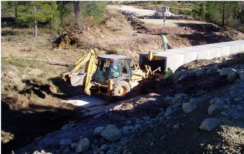
3. RELLENO DEL TRASDÓS: El relleno del trasdós debería comenzar tan pronto como fueron colocados los marcos. Debería compensarse las zanjas hasta la altura de la parte superior del marco, rellenando alternativamente sobre los dos lados, utilizando los materiales granulados seleccionados, compactados con la ayuda de un compactador ligero o a mano, en capas que no excedan de
