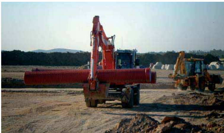
En el transporte de tuberías plásticas también se utiliza maquinaria, al igual que sucede con las tuberías de hormigón
