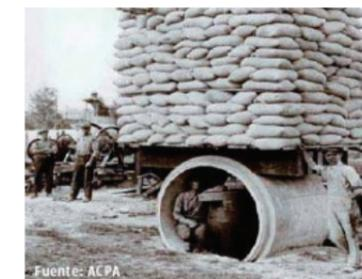
La única modalidad de instalación que ofrecen las tuberías plásticas es en zanja, mientras que las tuberías de hormigón armado pueden instalarse en zanja, en terraplén, en zanja inducida en terraplén o por hinca, según resulte más conveniente. Las tuberías de hormigón armado son resistentes por sí mismas.
