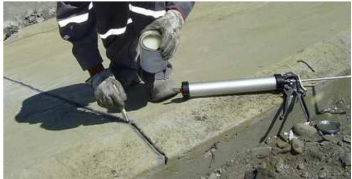
Fig. 4 Aplicando puente de unión
