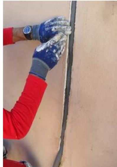
Fig. 2 Colocación de fondo de junta.
