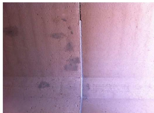
Fig. 6 Tramo de junta con sellador
