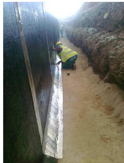
Fig. 7 y 8 Haciendo presión sobre la banda asfáltica
